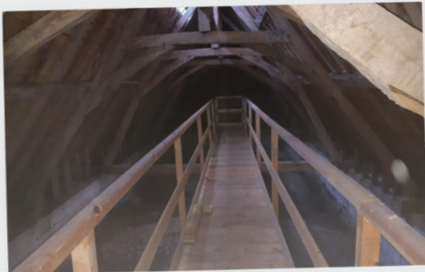
Passerelle technique dans les combles de la nef centrale dont charpente et couverture refaites à neuf
